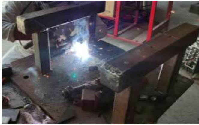
Figura 5: Proceso de soldadura por arco eléctrico del chasis superior.
